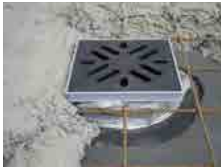
8. Pour out with concrete
